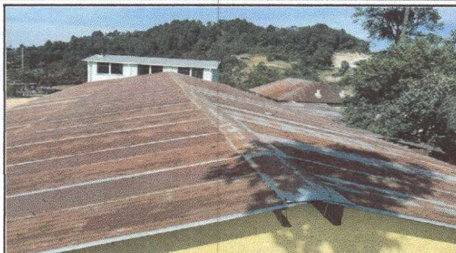
Foto 2:Sustruccion de capote de lamina para lamina troquelada
