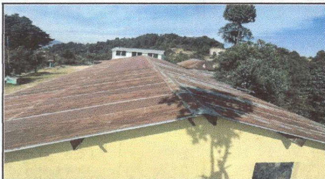
Foto1: Sustruccion de lámina, por lámina troquelada aluzinc calibre 26
