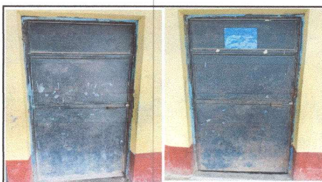
Foto 4: Sustruccion de puertas
